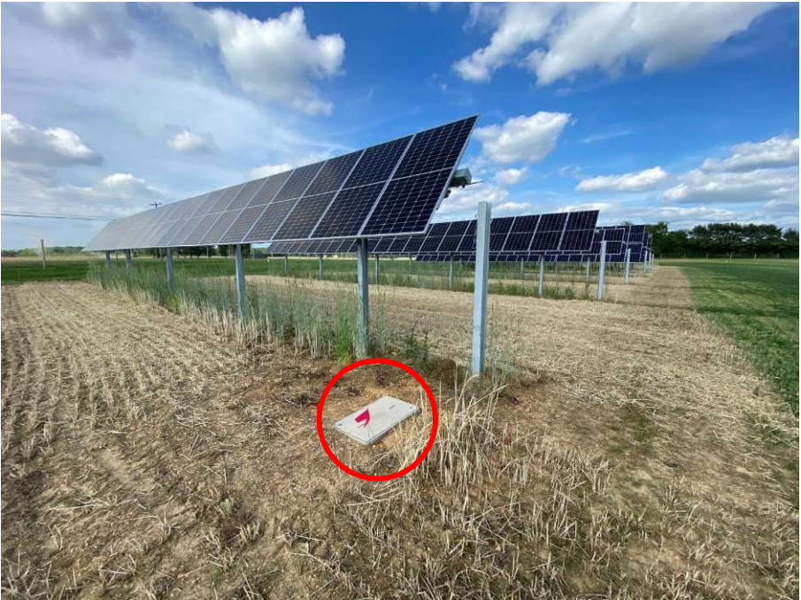
Placement of conduit boxes
